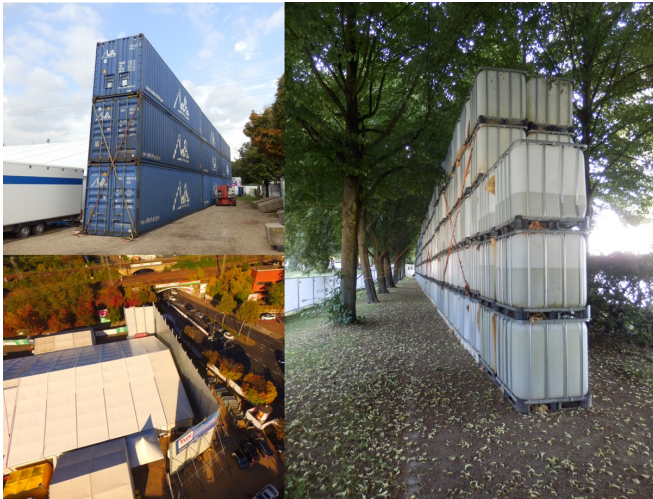
Abb. 13: Klassische Minderungsmaßnahmen bei Veranstaltungen in Form mobiler Schallschutzwände. Exemplarische Ausführungen als Seecontainerwand, Modulwand oder mit IBC-Containern.
