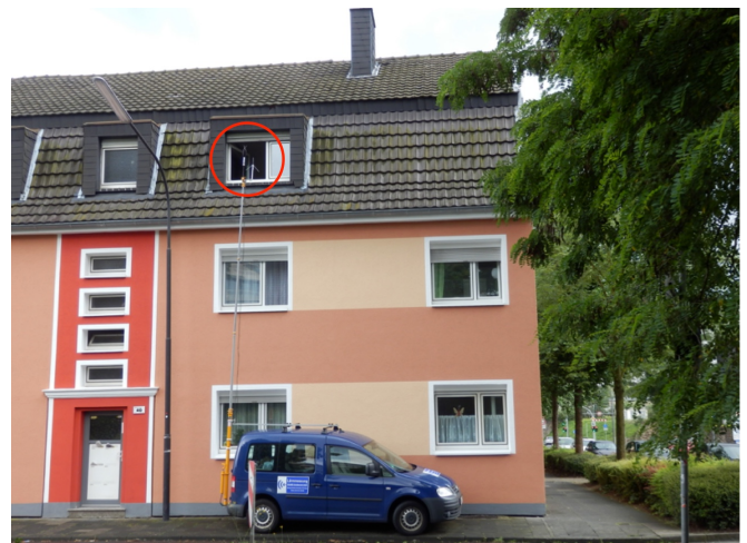
Abb. 9: Normgerechte Messung in d = 0,5 \text{ m} vor dem geöffnetem Fenster.
